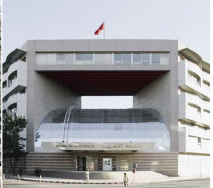
Bank Al-Maghrib, Bürogebäude; Rabat, Marokko
